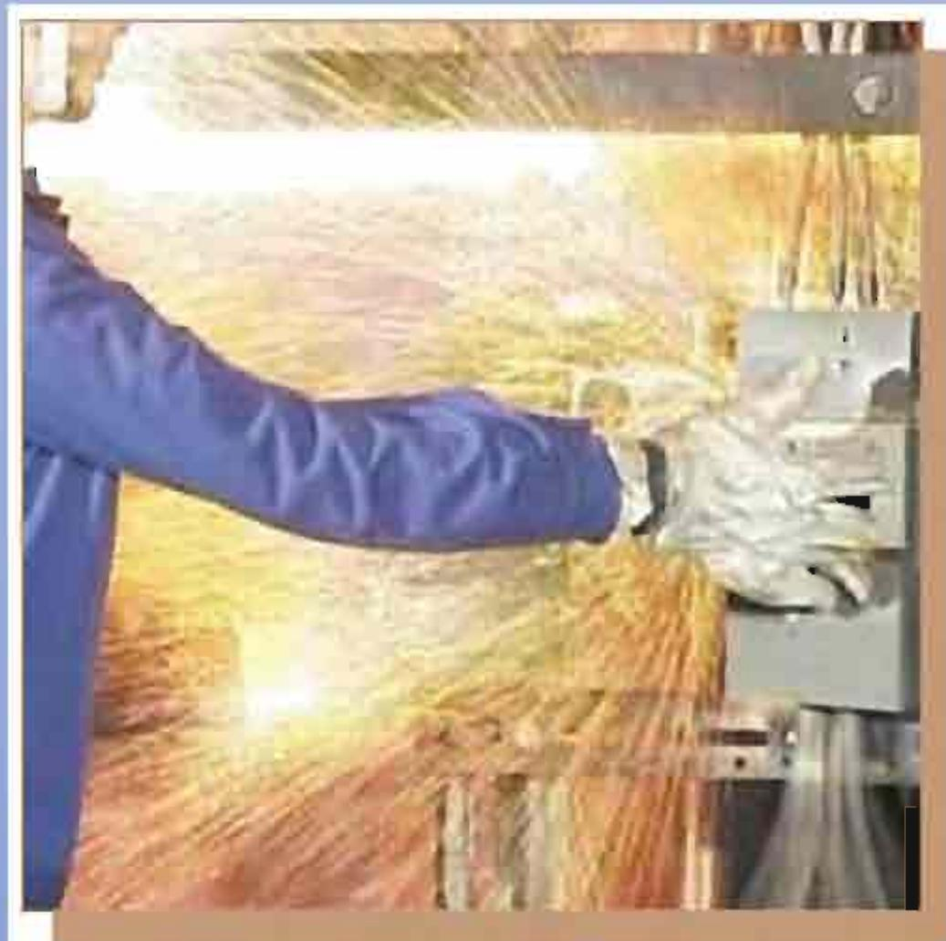
Fig. 2.14 - I materiali incandescenti prodotti dall'arco possono innescare sostanze combustibili anche lontane (l'interruttore apre una corrente superiore al suo potere d'interruzione).
