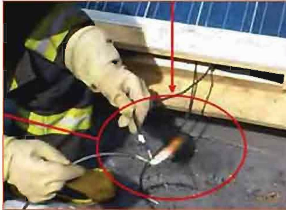
Fig. 5 - Arco elettrico in corrente continua in un impianto fotovoltaico da 6 kW.
